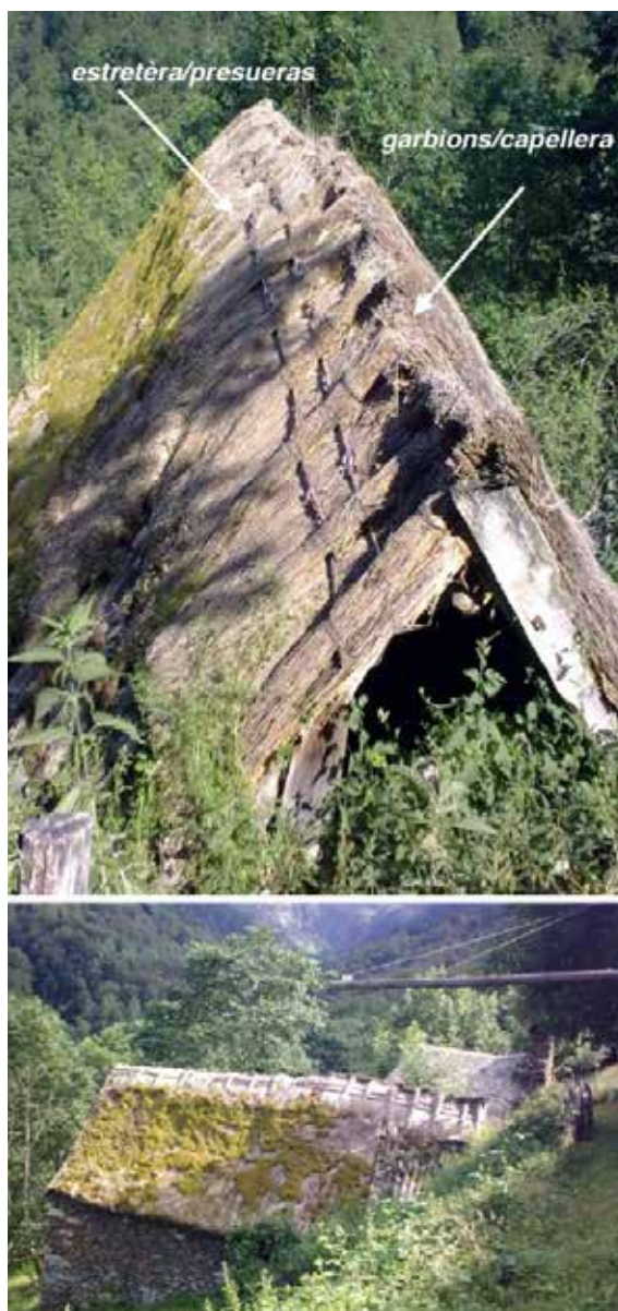
Fig. 14. Detall de la coberta de la borda de Bordius, any 2009. Imatges cedides per Maria Aran Costa Riu (Costa 2013, 5, fig. 113 i 18, fig. 155).
