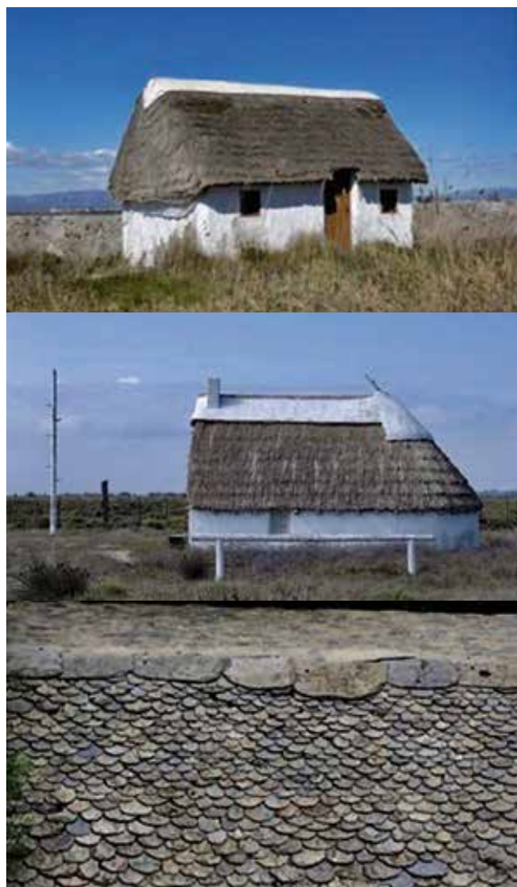
Fig. 13. Diferents proteccions del carener actuals segons formes de fer tradicionals. 1. Construcció tradicional a l'Ebre. Barraca del Delta de l'Ebre (Ecomuseu del Delta de l'Ebre). 2. Rèplica de cabana du gardian de principis del segle XX al Parc Natural Regional de la Camarga (França). 3. Protecció de lloses de pissarra que es pot veure actualment a diferents construccions d'Andorra.
