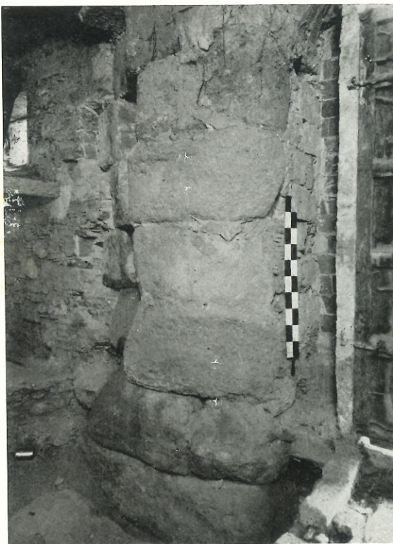
Fig. 118. — Porta Rufina : Pilar que serveix de brancal a les dues portalades de la Porta Rufina. En el tercer carreu començant per baix és ben visible el desgast produït pel fregadís dels botons de les rodes dels carros que giraven en l'estret passadís en angle del portal. Com que dit passadís era en pendent el senyal del fregadís està inclinat
