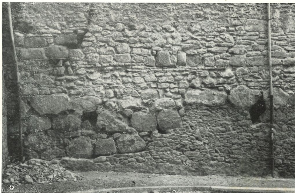
Fig. 124. — Part de llevant del mur de Casa Pastors a la placeta superior de St. Feliu tocant a la torre de Sobreportes. Blocs calissos de tècnica ciclopia, aparell petit amb morter, filades sorrenques a la part superior esquerra
