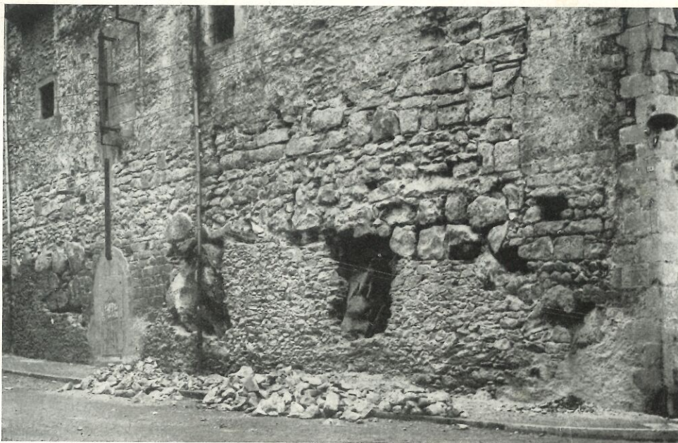
Fig. 123. — Part de ponent del mur de Casa Pastors a la cantonada de la pujada i placeta superior de St. Feliu. En el fons dels esborancs es veuen les roques que sustenten el mur
