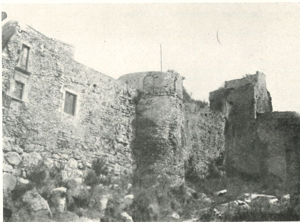
Fig. 109. — Girona : Tros de mur del pati de l'Estudi general o les Agües. En la part inferior els grans carreus irregulars ciclopis. En el centre la torre rodona. En últim terme la torre quadrangular del telègraf, aixecada sobre un fonament romà
