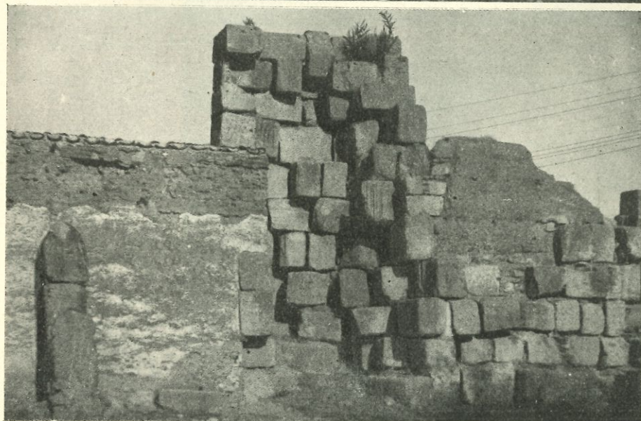
Fig. 4.—Torreón del lienzo noroeste de la muralla de la Alcazaba, del que quedan únicamente los sillares de su paramento exterior.
