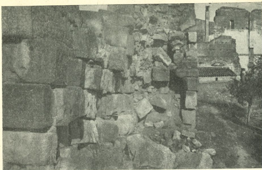
Fig. 5.—Segundo torreón del lienzo de muralla noroeste de la Alcazaba, cuyo estado de ruina permite observar los caracteres del relleno de la misma. Los sillares visibles a la izquierda, antes de llegar al torreón, corresponden a la parte interna del paramento exterior.
