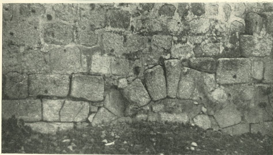
Fig. 3.—Puerta tapiada en el lienzo sudeste de la muralla de la Alcazaba, cubierta por la tierra hasta cerca de la clave del arco.
