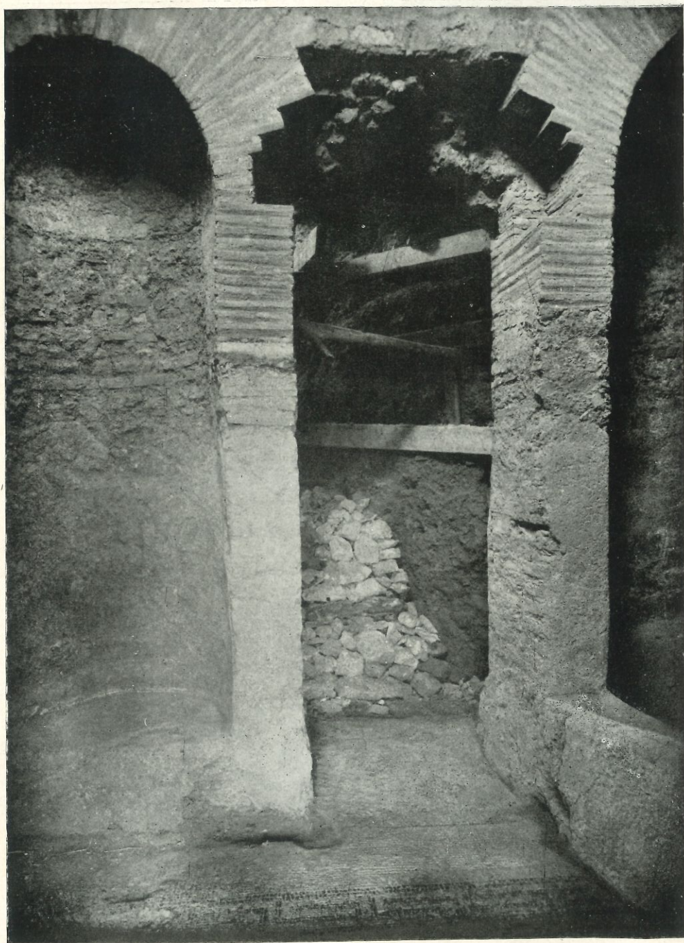
San Baudilio de Llobregat.—Excavaciones de la "villa" romana. Portal de comunicación entre el apodyterium y el caldarium (este último todavía por excavar). Los arcos que corren sobre las hornacinas que flanquean el portal han sido reconstruidos precisamente en su parte inferior para asegurar la estabilidad de la parte alta, que es antigua.
