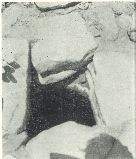
21 —Pozo superior de San Marcial. En las piedras interiores se ven señales del roce de las cuerdas.
