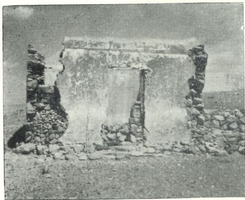
15.—Papagayo, Lanzarote. Casa de la que han sido arrancadas las esquinas de piedra, para reaprovecharlas
