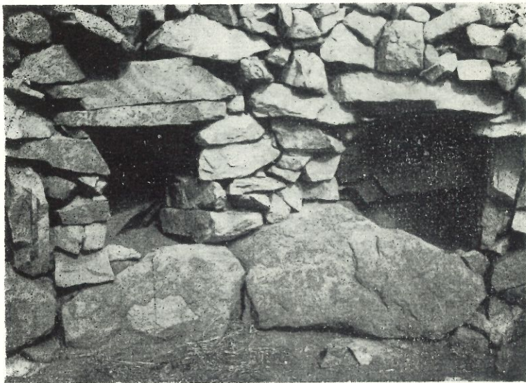
10.—Torres de Lara, Fuerteventura. Detalle de los cubículos interiores, reservados en el grueso del muro
