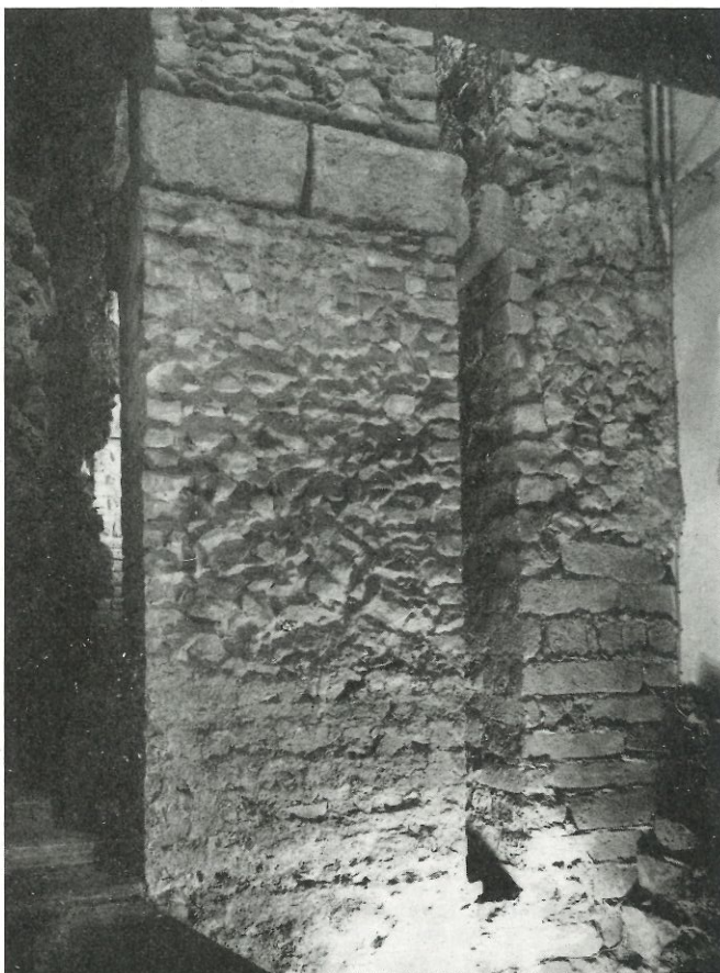
Parte inferior de los dos pilares más próximos a la ciudad del doble acueducto de la «Plaça Nova», en la planta inferior de la torre número 1 (la imposta de grandes sillares del pilar de la izquierda corresponde a la parte inferior de la fotografía siguiente)
