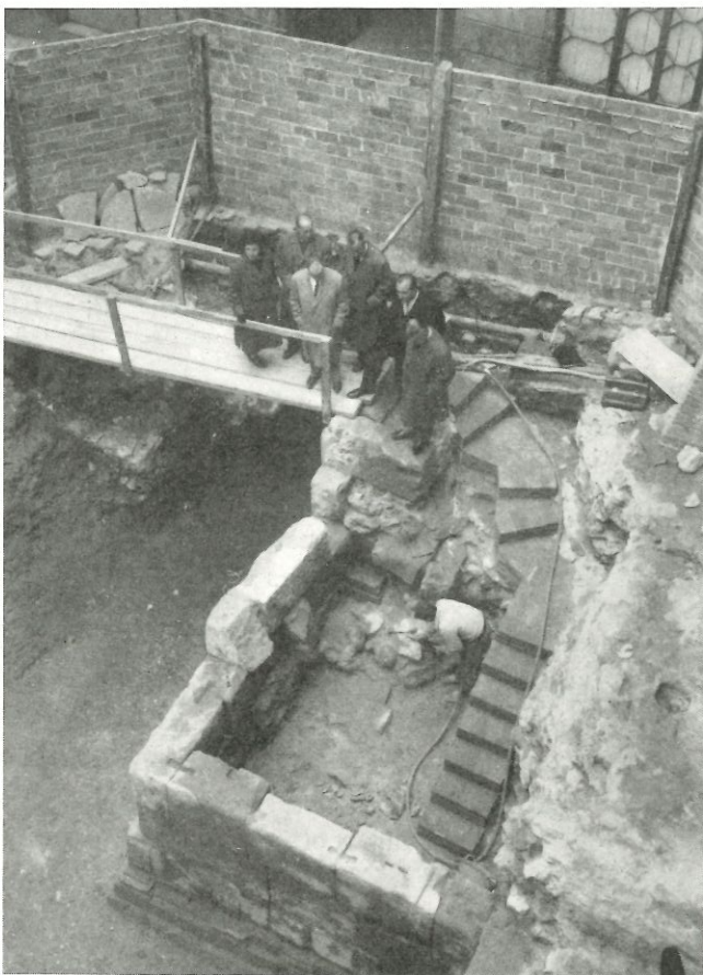
Interior de la torre 26, el 19 de diciembre de 1959, al ser puestas a la luz las testas marmóreas allí descubiertas incorporadas al mortero. (La escalera que desciende a él fue construida a los fines de la excavación y es, por lo tanto, moderna.) Obsérvense los encajes para las uniones de los sillares.
