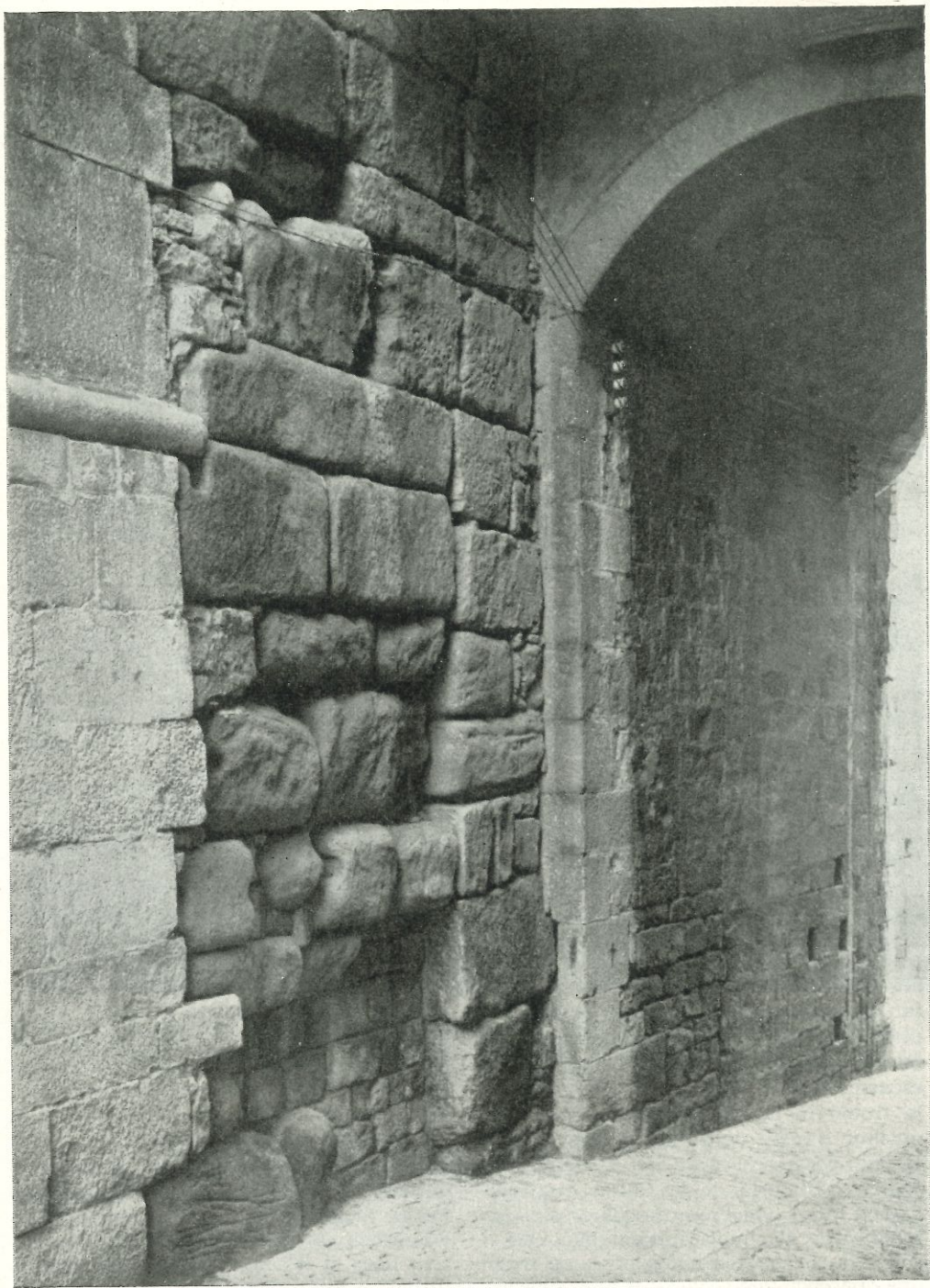
Girona. El portal de Sobreportes, en el camí de les Gàl·lies. Hi veiem el parament de grans carreus de pedra arenosa, ben separades en els dos segments del portal; a l'esquerra, la muralla, i, a la dreta, la torre, la construcció de la qual està tapada per obra posterior.
