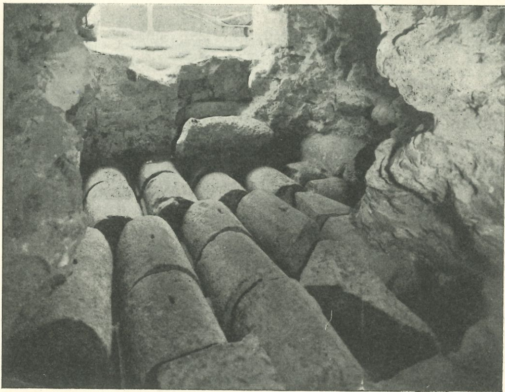
Barcelona. Interior de la torre 23 de la muralla romana del segle III, un cop buidada la part inferior fins a deixar al descobert les pedres semicilíndriques que formaven part de monuments sepulcrales i que foren soterrades a la seva base.
