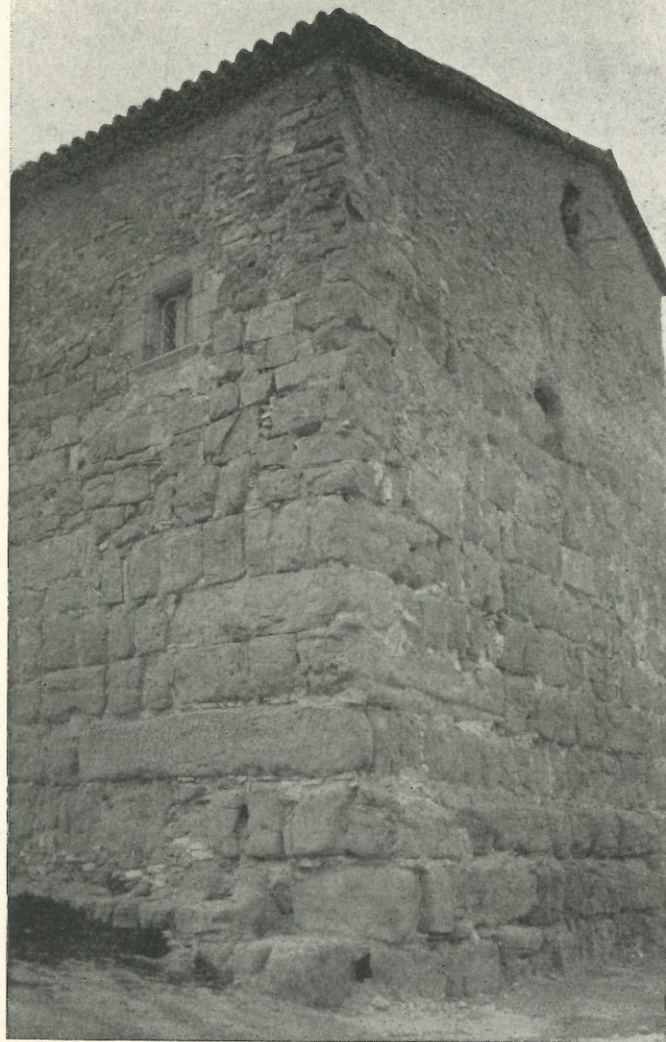
La Ràpita (com. la Noguera). Torre de guaita (de planta quadrangular) feta de grans carreus sorrencs fortament erosionats. La part antiga arriba a la sisena filada, únicament.
