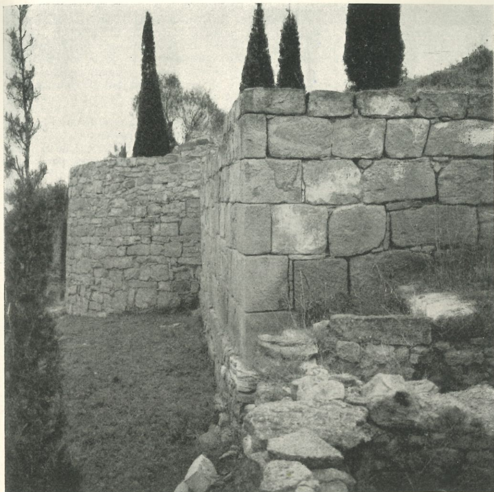
Ullastret. En primer terme, una de les torres quadrangulars; i una de circular, al fons. Hom pot observar la gran diferència que hi ha entre els respectius paraments; això fa pensar en diferents èpoques de construcció.
