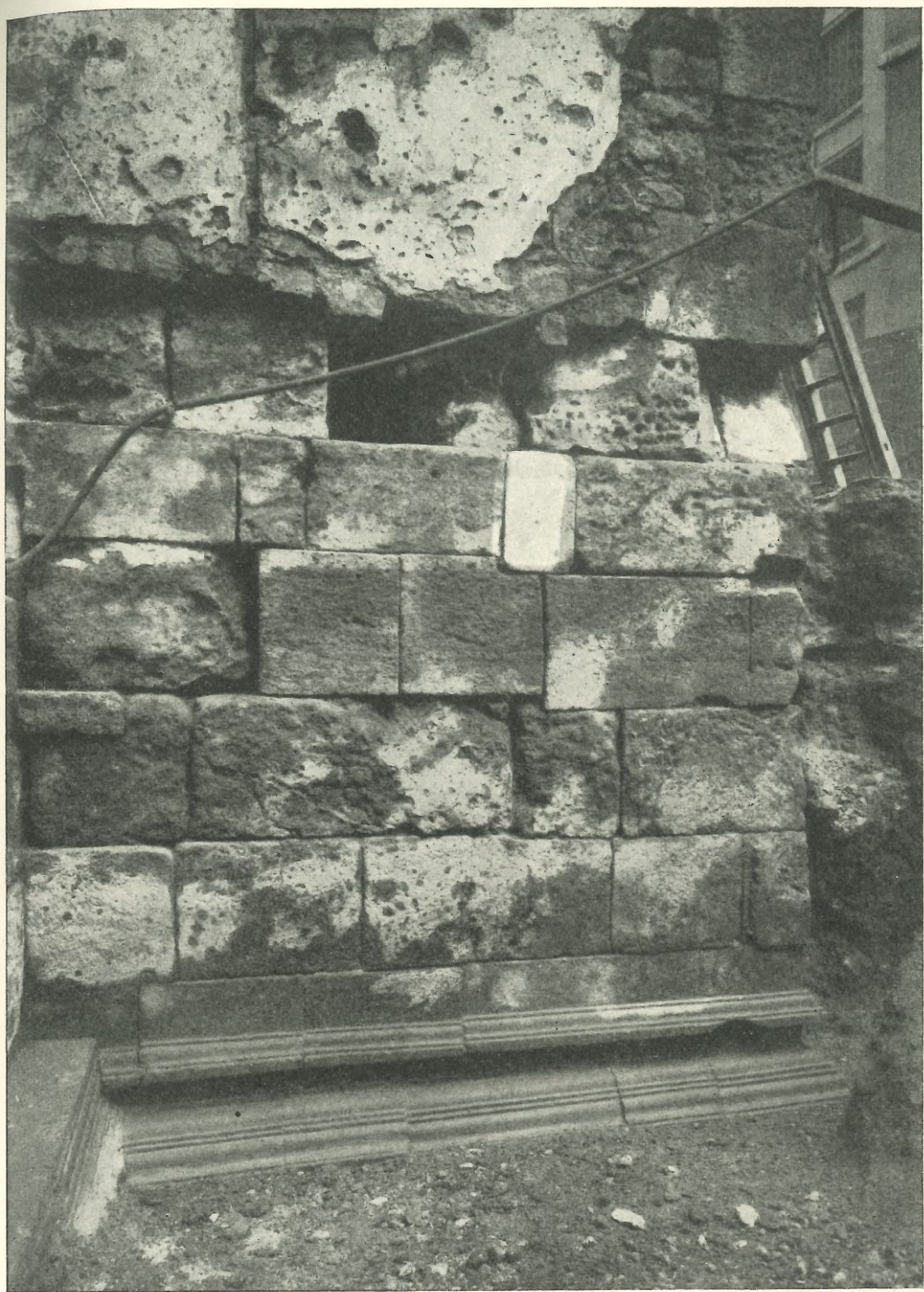
Barcelona. Parament esquerre de la torre 25 del recinte romà del segle III. Les pedres que formen el basament són una cornisa invertida i aprofitada decorativament.
