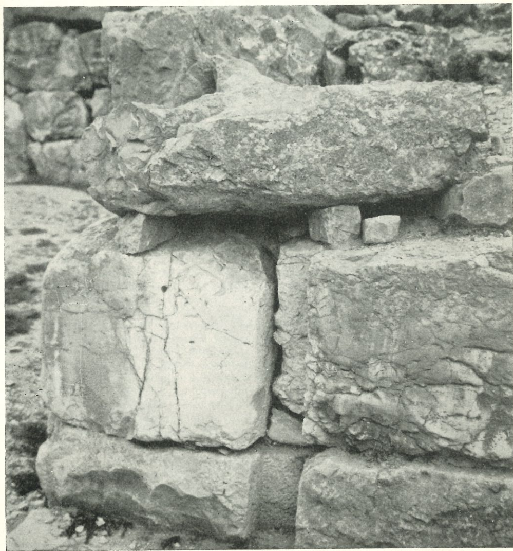
Empúries. Portal de la Neàpolis grega. És ben visible el séc per a col·locar el rastell, reixa o porta vertical que el tancava. Correspon a la banda esquerra entrant. La pedra superior és superposada modernament.
